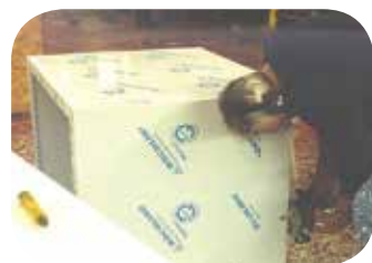
Las soldaduras son rebajadas para dejar una junta lisa y limpia
